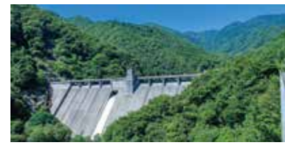
高さ59.2mの重力式コンクリートダム
